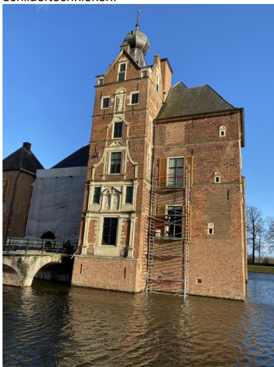
Vorbereidende en uitvoerende werkzaamheden bij onderhoud en restauratie van schilderwerk aan monumenten
