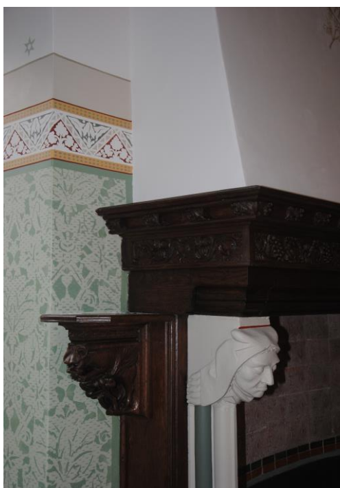
Binnenschilderwerk op steen afgewerkt met decoratief sjabloneerwerk
