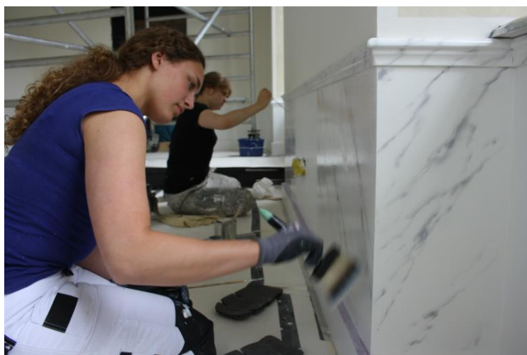
Het aanbrengen van een imitatie witmarmer
