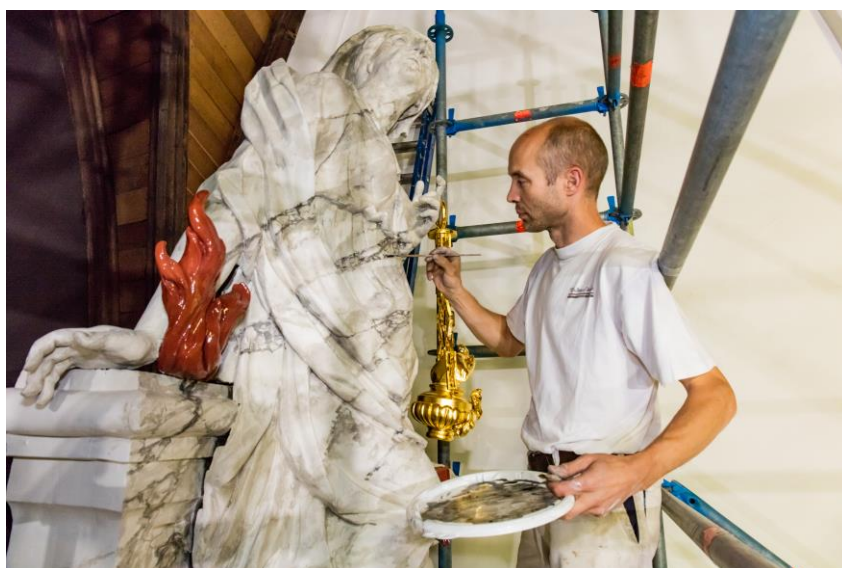
Bij de restauratie van het orgel in de Oude Kerk te Amsterdam werden verschillende bijzondere schildertechnieken toegepast t.w. houtimitatie, marmerimitatie en verguldwerk
