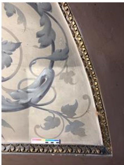
Proefstuk om een goede reiniging te verkrijgen
